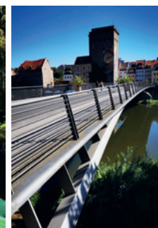
Brücke ins Nachbarland
